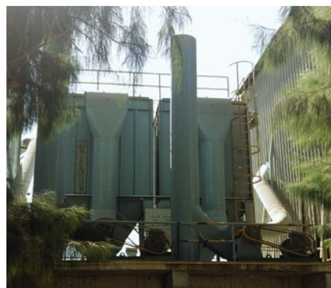
มีระบบบำบัดอากาศ (เครื่องดักฝุ่นแบบถุงกรอง)
